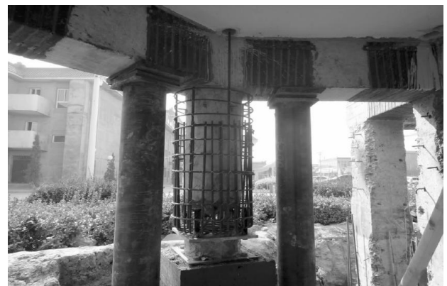
(b) 施工中的框架结构节点
