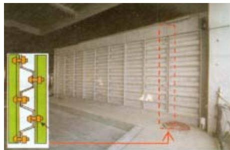
图 8 波纹钢板阻尼墙
