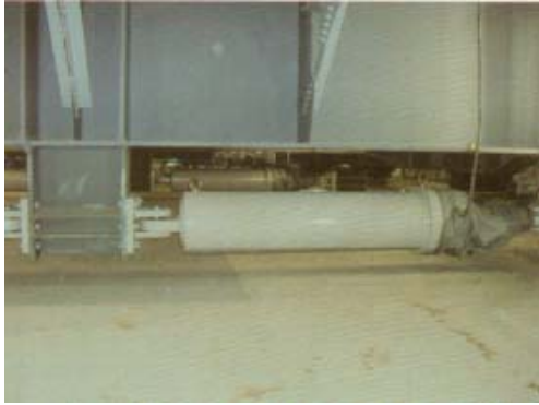
图 4 可控油压阻尼器
