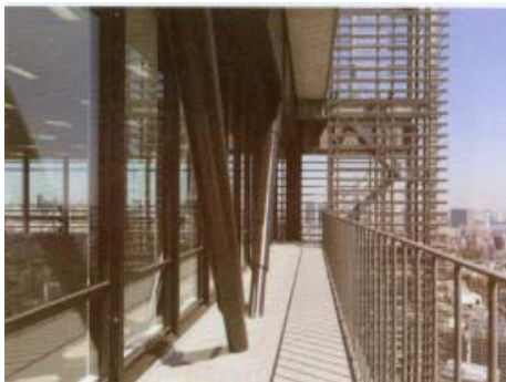
图 5 V 形粘弹性阻尼支撑
