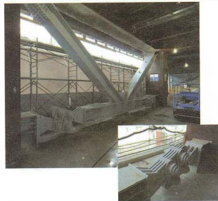
图 7 回转摩擦阻尼器
