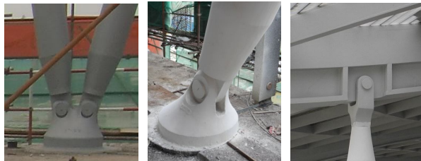
(a) V 形柱脚节点 (b) 人字柱脚节点 (c) 柱顶节点 图 30 销轴节点
