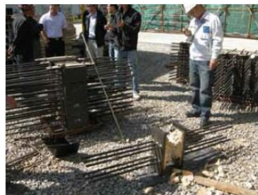
运抵现场的钢滞变阻尼器
