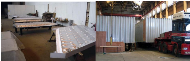
图 7 在墙面板内安放隔热层 图 8 膳宿模组完成待运
