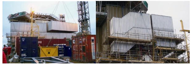
图 9 安装膳宿模组 图 10 将新生活模组与既有生活区连在一起的步行道模组之一
