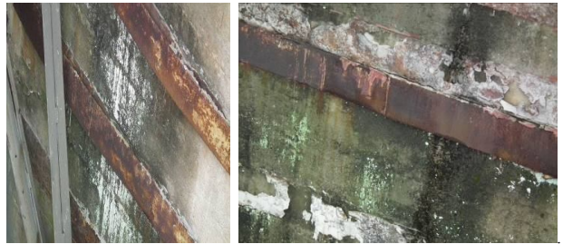
图 1 湖南某水库 1998 年粘钢加固的钢筋混凝土闸门
