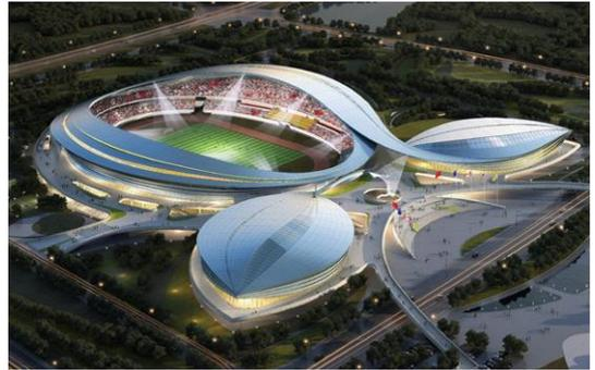
其中体育场上四层的,整体结构呈“椭圆”形,椭圆屋盖长轴长为237.66m,短轴长为205.9m,结构标高46.5m。体育场屋盖为车辐式索承网壳结构,上弦结构由72根径向梁组成,径向梁末端为悬挑桁架结构;环向由1圈外环矩形钢梁和1圈内环桁架以及环向连系梁组成;屋盖下弦结构由撑杆和拉索组成,撑杆和上弦交接处设置环向连系梁,整个屋盖支承于下部结构外围一圈框架柱顶上,框架柱顶之间设置沿体育场一周的钢筋混凝土环梁。钢筋混凝土环梁上方设置屋盖巨型钢环梁,位置在各根径向索支座端部。
