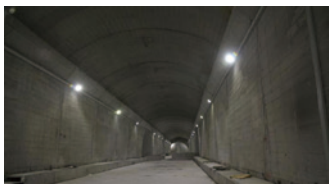
岳武高速明堂山隧道
