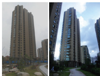
高层住宅基础控沉加固（浙江 2012）
