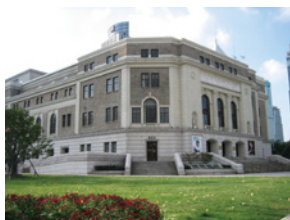
上海音乐厅整体平移顶升工程
