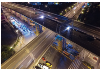
上海市中环线沪太路钢箱梁复位工程
