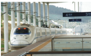
宁杭高铁客运专线
