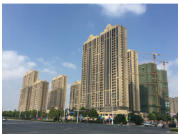
高层住宅小区基础加固（江苏 2015）
