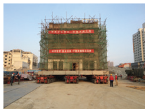
徐州市同和裕银号平移工程
