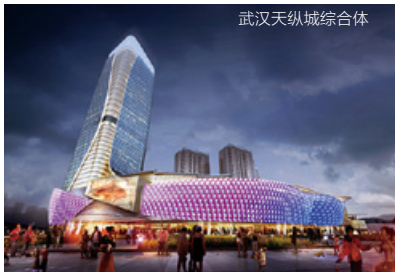
武汉天纵城综合体
