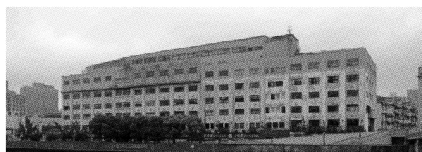
沿苏州河立面现状照片,深色为六七层加建部分。图片来源:邱致远摄
