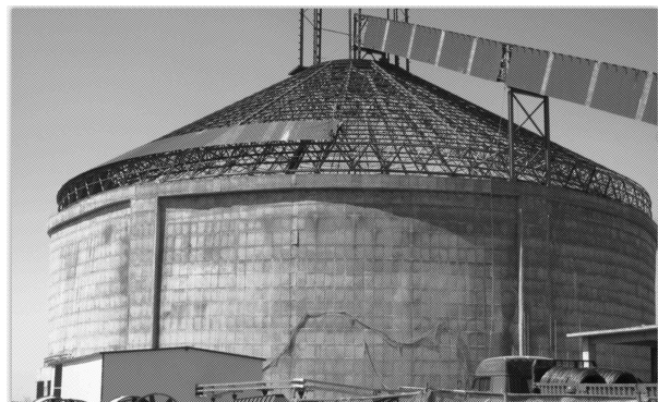
图5 熟料库网架屋面板安装
