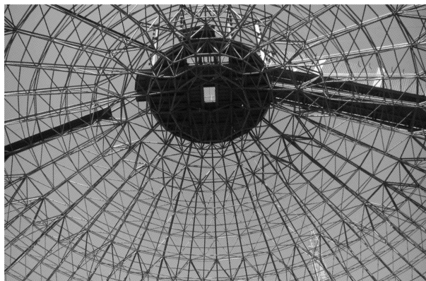
图4 熟料库网架杆件安装
